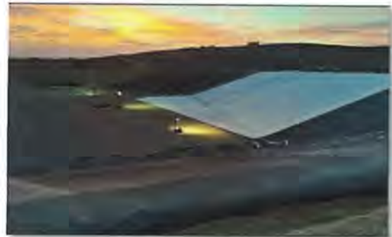
Module 2 Taft Landfill
